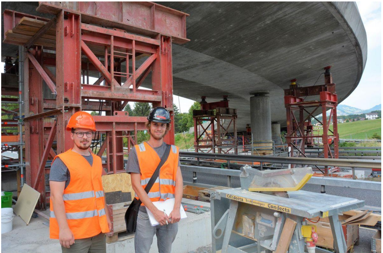
Astra-Mediensprecher Lukas Studer (links) und Bauingenieur Fabio Hofer stellen die Sanierung der Autobahnbrücke im Spiezwiler vor.
