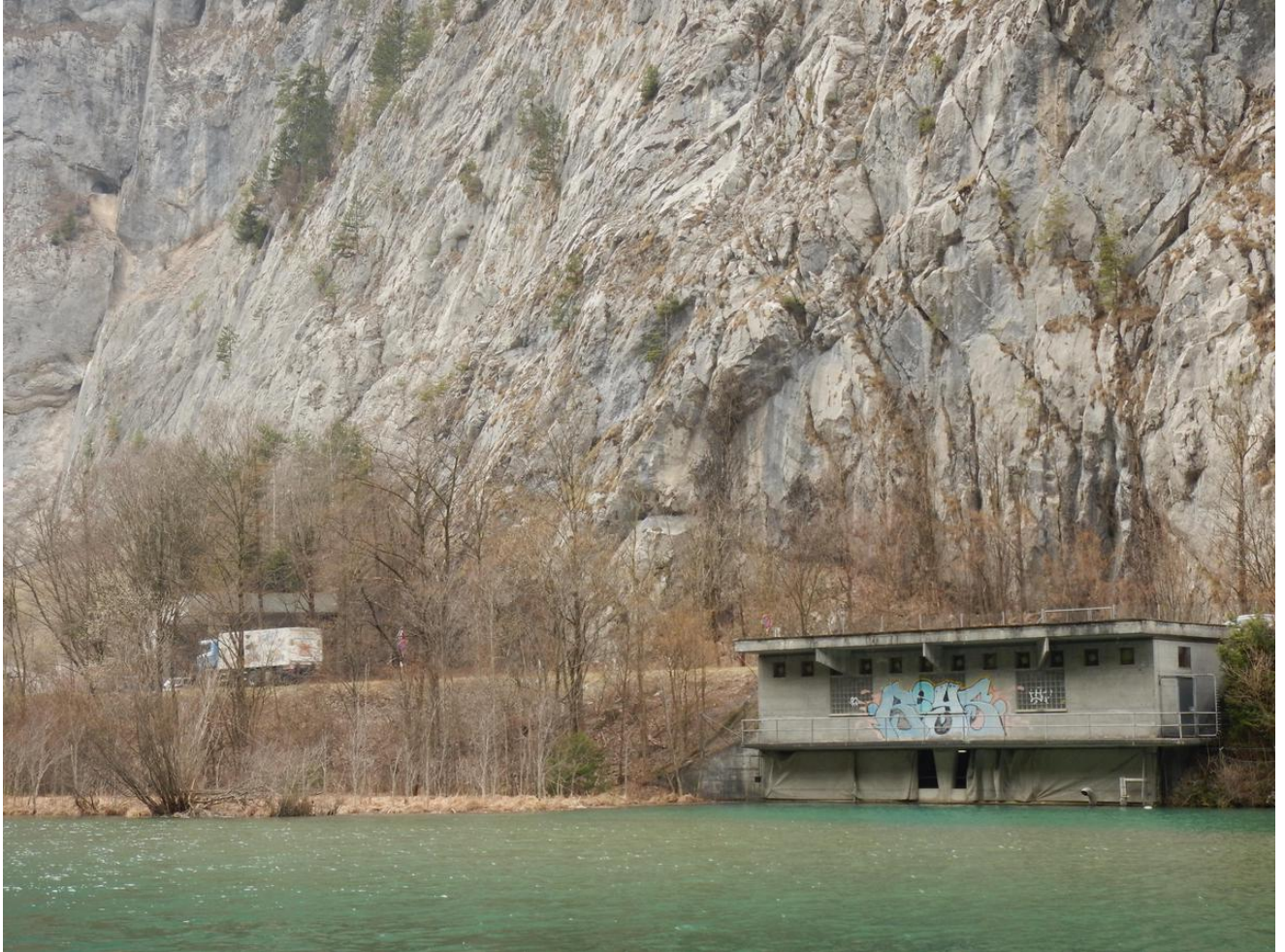
Das Kraftwerk Simmenfluh von der Burgholzstrasse aus gesehen: Rechts der Auslauf, links beim Lastwagen der Zugang zur Kaverne, links oben das Wasserschloss. Foto: Guido Lauper
