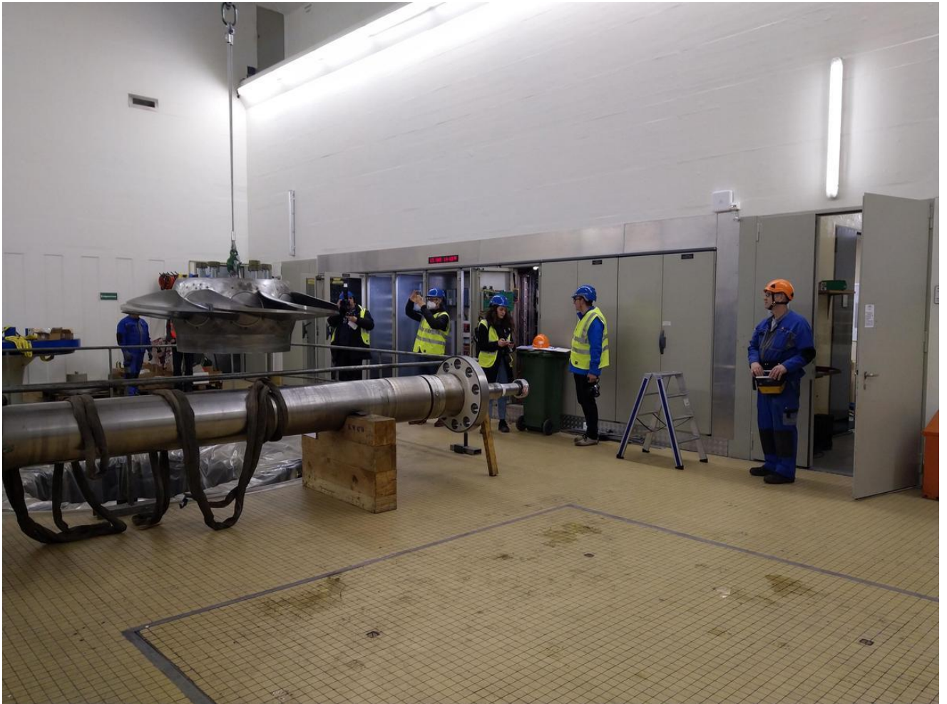
Montageleiter Paul Jakob verschiebt das Laufrad mit dem Kran. Foto: Guido Lauper
