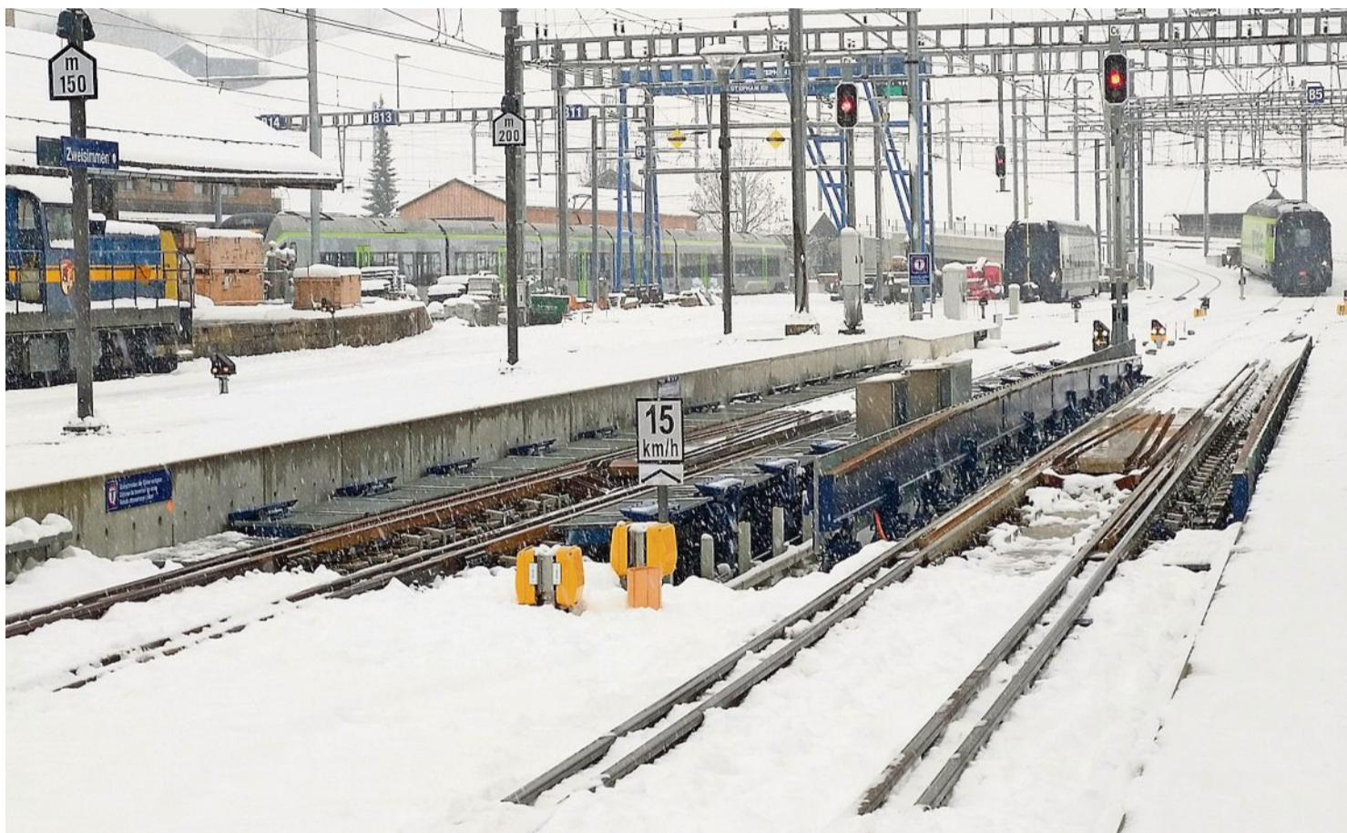
Die Umspuranlage funktioniert auch bei Schnee und Frost einwandfrei. Im Hintergrund die BLS-Lok mit dem Interface-Wagen. Fotos: Guido Lauper
