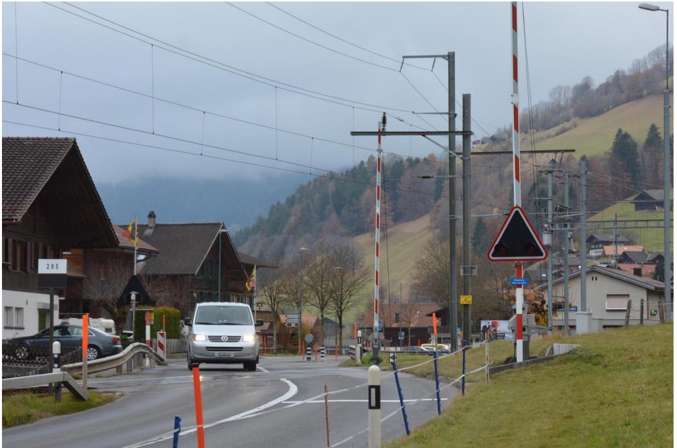
Die Barriere wird um 150 Meter Richtung Spiez versetzt. Foto: Guido Lauper
