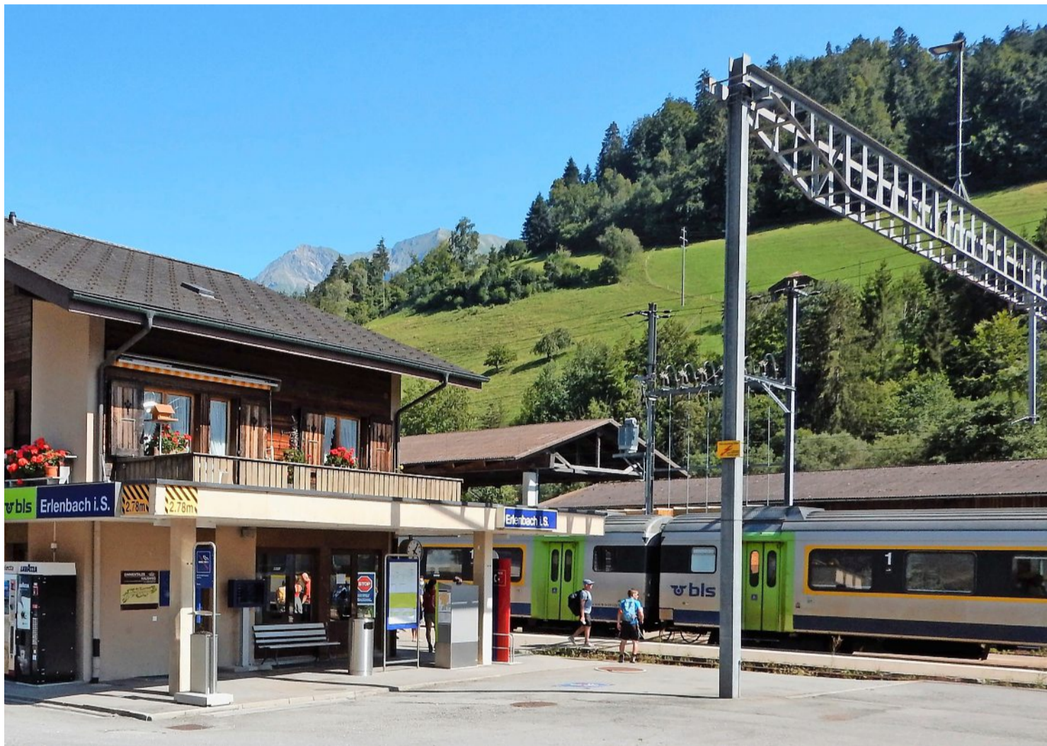
Einsprachen verhindern weiterhin den Um- und Ausbau des Bahnhofs Erlenbach. Foto: Guido Lauper
