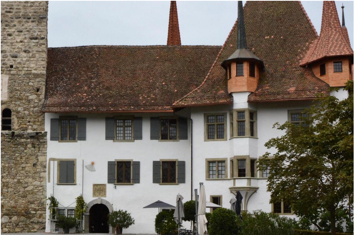
Die renovierte Fassade des Schlosses Spiez. Foto: Guido Lauper
