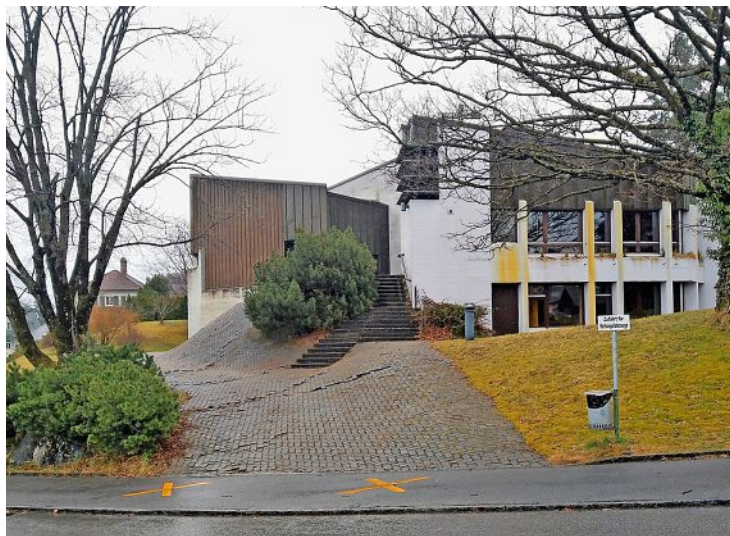
Das Kirchenzentrum von der Belvédèrestrasse aus gesehen: Die Einfahrt wird saniert, die Holzfassade ausgewechselt. Zudem werden die Steine des Hügels durch Begrünung ersetzt. Foto: Guido Lauper
