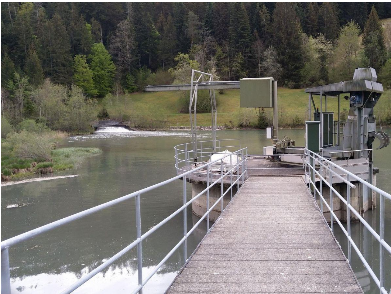
Der Aegelsee mit dem Einlaufbauwerk und dem Zufluss aus Chirel und Fildrich (links hinten). Foto: Guido Lauper
