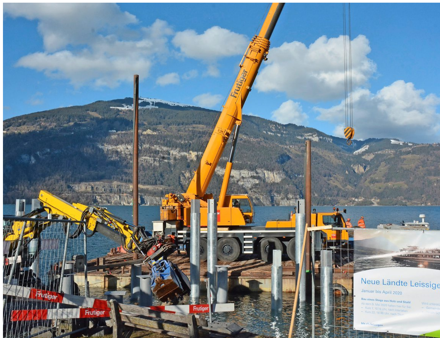
Neue Ländte Leissigen: Arbeiten mit schwerem Gerät, damit am 9. Mai die ersten Kursschiffe anlegen können. Foto: Guido Lauper
