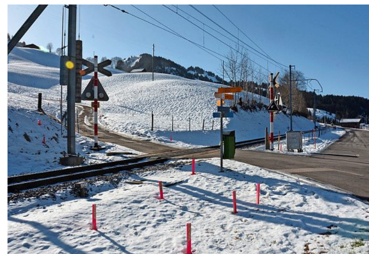
Dieser Bahnübergang an der Oeschseite wird mit Barrieren gesichert und die Strassenführung angepasst. Im Vordergrund die Profile für die neuen Technikgebäude. Fotos: Guido Lauper
