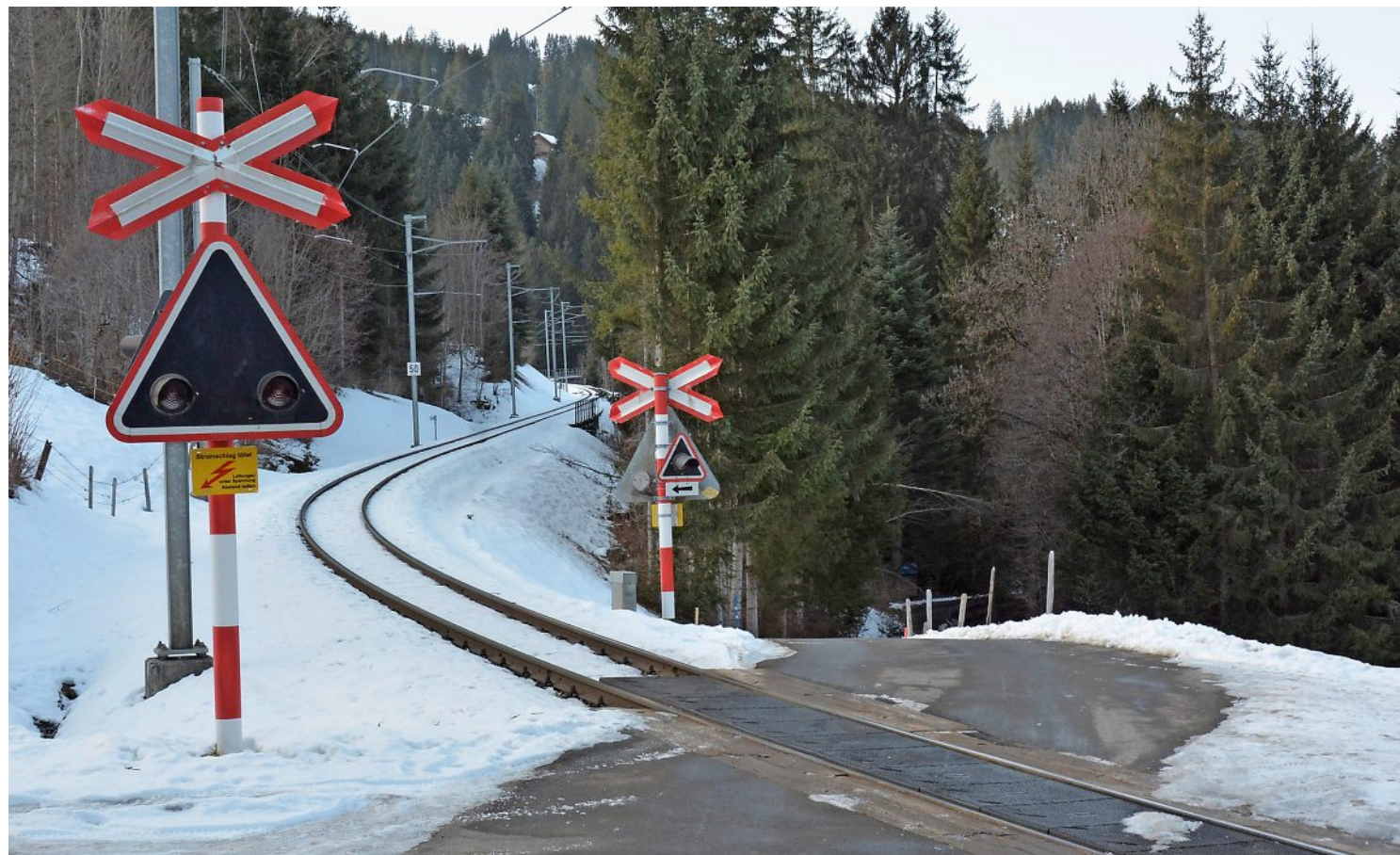
Der Bahnübergang Spitz wird aufgehoben. Rechts die ins Tal führende Alte Saanenmöserstrasse.
