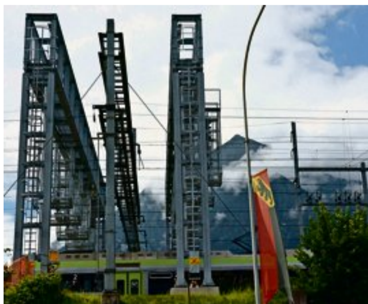
Modernisierung im Bahnhof Spiez: Die neue Signalbrücke im Doppelpack ersetzt zwei alte Träger.
